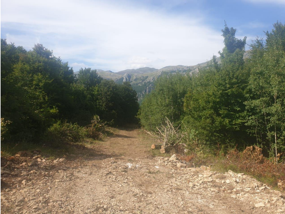
Slika 2: dio trase dalekovoda.
