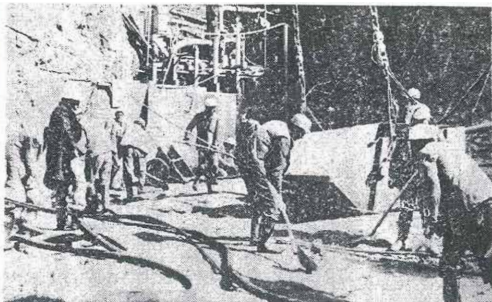
ПРИПРЕМА БЕТОНА ЗА ТЕМЕЉЕ БРАНЕ ХЕ „МРАТИЊЕ“
