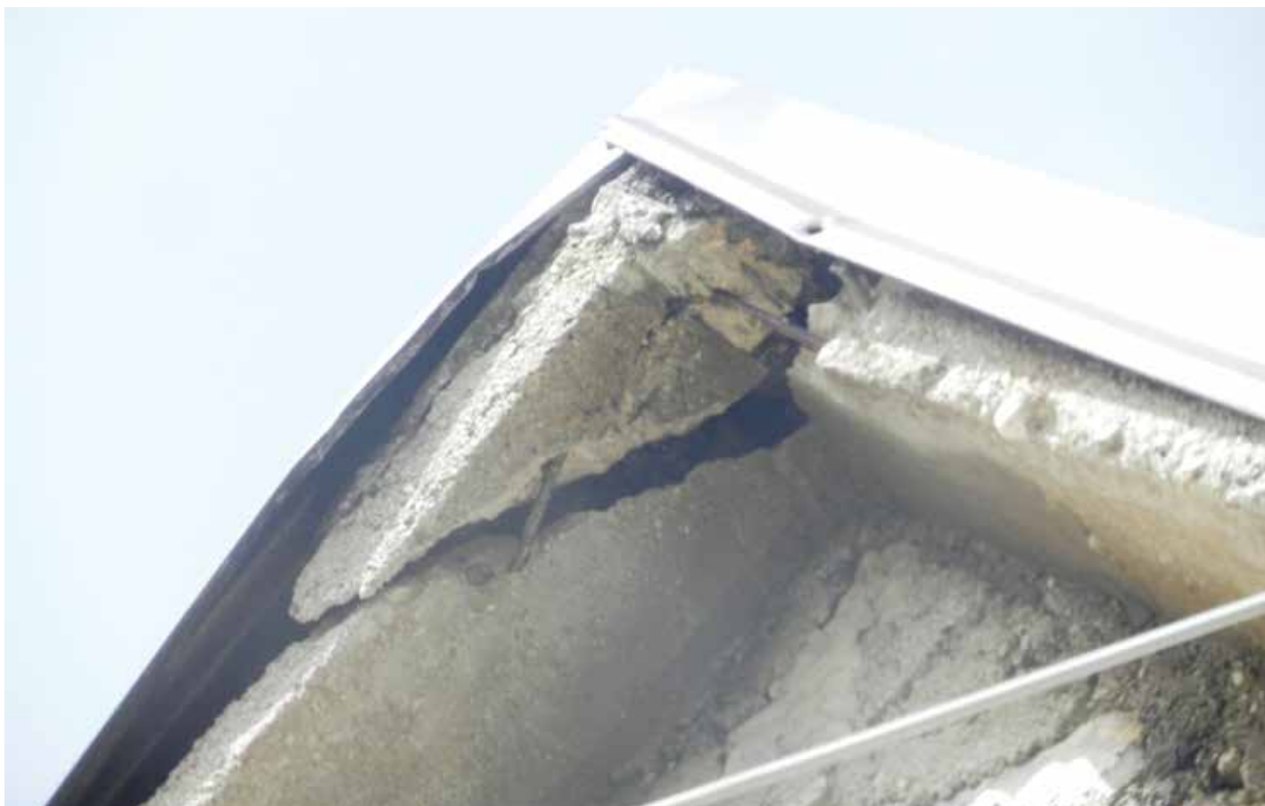
Оштећења на кућама након земљотреса
